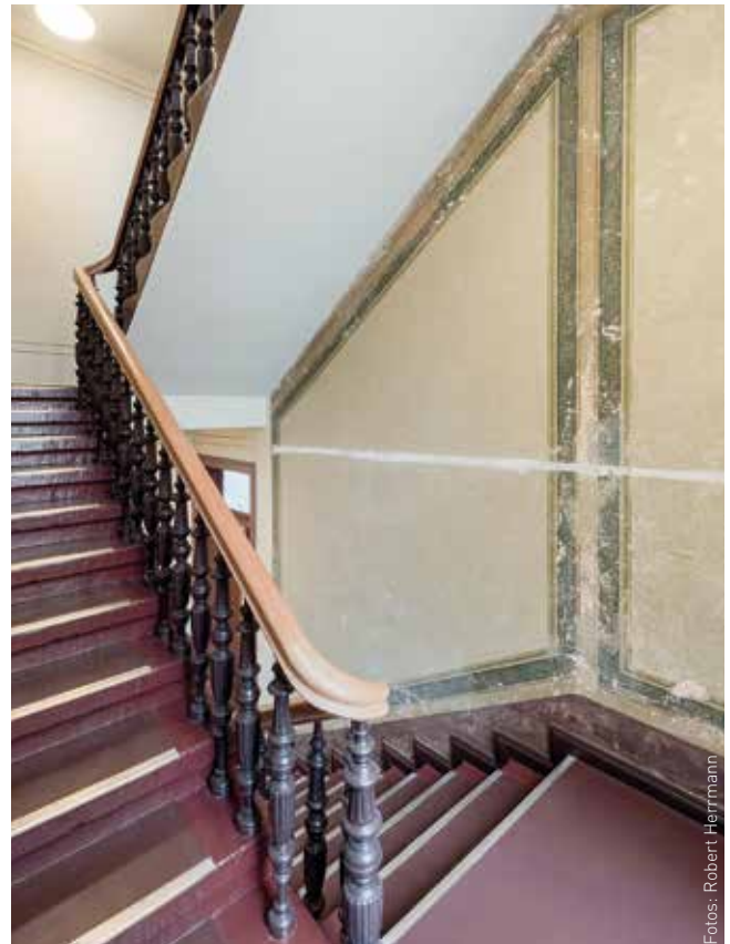
In dem Projekt „Neue West“ des Büros AHM Architekten wurde der historische Farbanstrich der Wand bis zum ersten Treppenhodest freigelegt.
