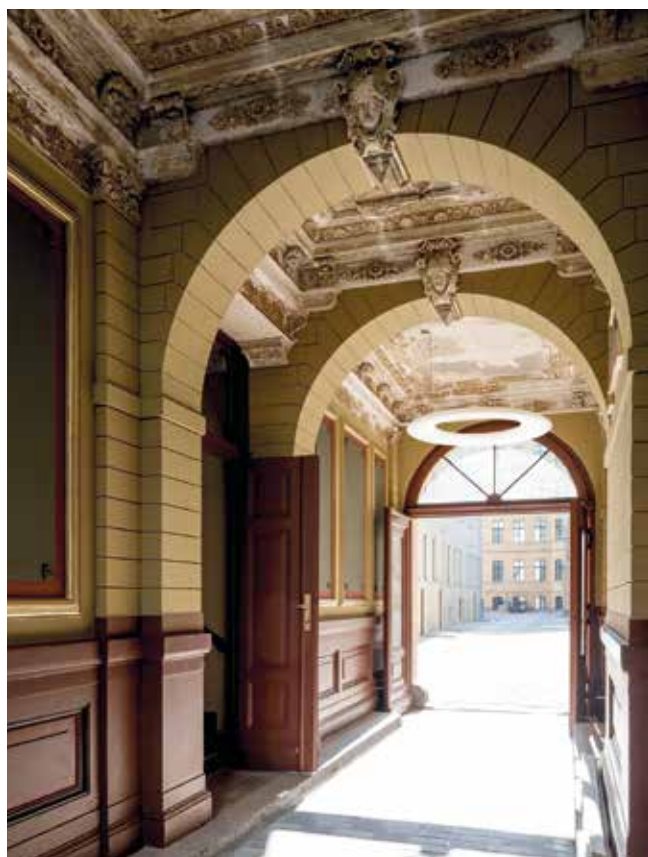
Auch an der Decke in der Tordurchfahrt wurde die historische Farbfassung freigelegt, während Wände und Bögen dem Farbfund entsprechend einen neuen Anstrich erhielten.
